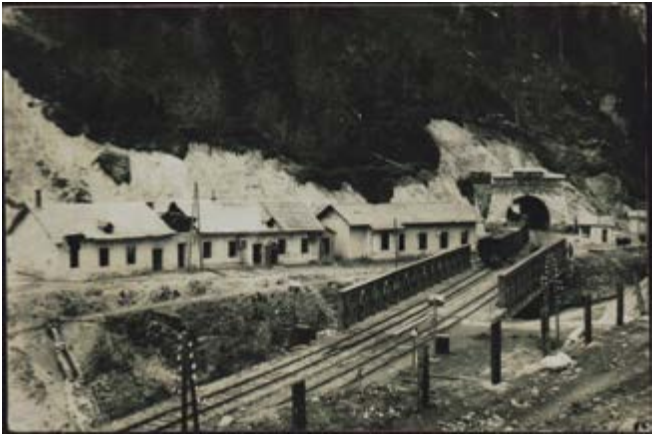
Slika 3: Karavanški železniški predor pri Področci, ok. 1919, iz zapuščine dr. Julija Felaherja (Vir: arhiv Koroške osrednje knjižnice)
