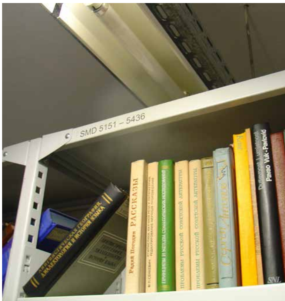
Električna napeljava (osvetljava) povsem blizu polic. (foto Kristina Košič Humar)
