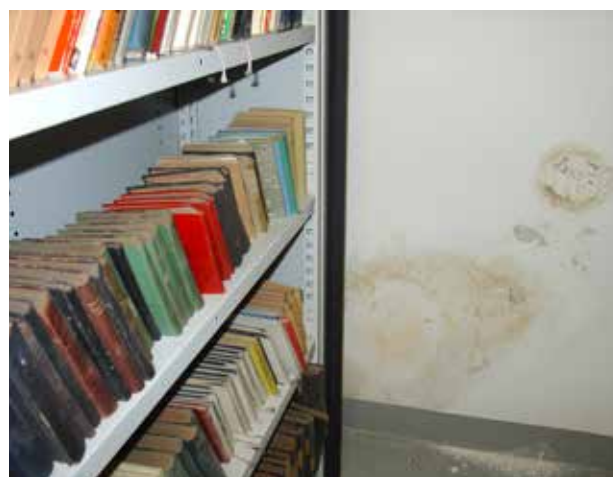
Vdor vlage skozi zunanjo steno - madeži na steni in plesen na knjigah (obkroženo). (foto Kristina Košič Humar)
